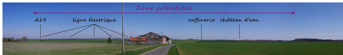
Fig.53: La zone potentielle depuis l'ouest
